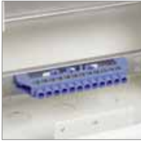
Рейка для кріплення шин N і PE.
