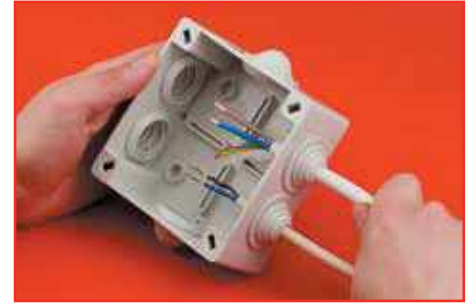
Етап 3. Введення кабелю Step 3. Insertion of cable
