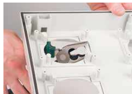
Для встановлення розетки на 32 А елементи з попередньою перфорацією необхідно видалити Pre-perforated elements must be removed to install a 32 A socket
