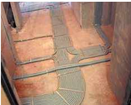
Приклади монтажу ПВХ-гофротруби (серія 9) Examples of installation of PVC corrugated pipes (series 9)
