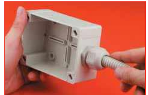
Етап 3. Введення труби і кабелю Step 3. Insertion of pipe and cable
