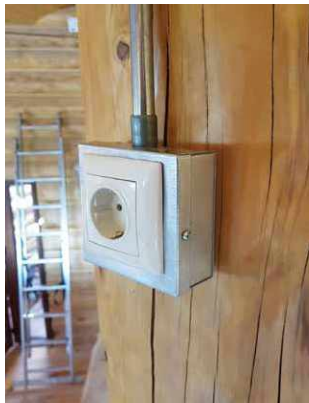
Трускавець. Котажне містечко. Монтаж кабельних систем по легкозаймистим конструкціям відповідно до вимог ПУЕ Cottage town in Truskavets. Installation of cable systems on combustible structures in accordance with the EIC requirements
