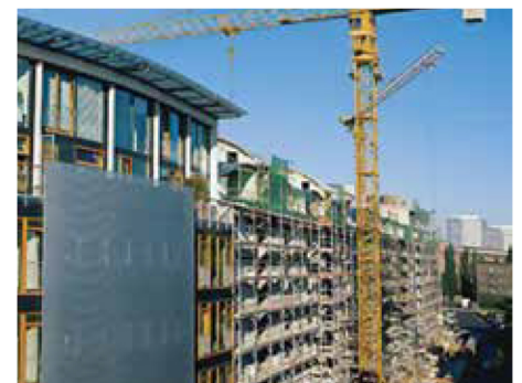
Строительство крупных торговых и складских комплексов
