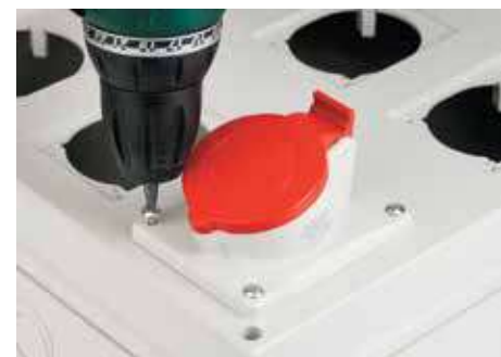
Монтаж розетки на 32 А
