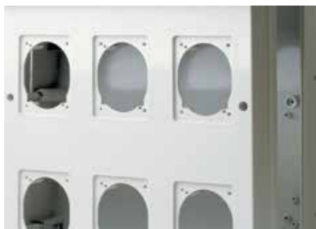
Стандартный фланец для установки розетки на 16 А
