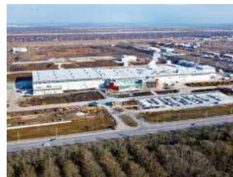
Административные помещения Здания аэропортов, морских и речных портов, вокзалов, промышленные предприятия, заводы и фабрики
