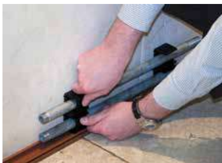
Универсальные держатели крепятся к стене, вплотную к основанию короба. В держателях фиксируются коммуникации
