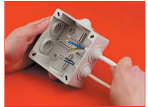
3 этап. Ввод кабеля
