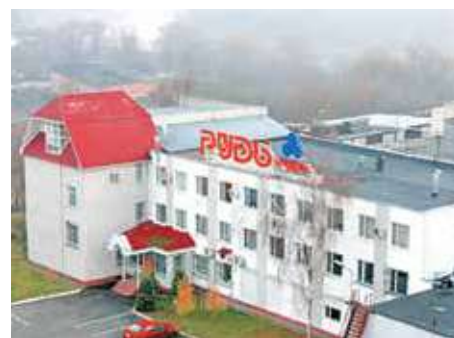
Холодильная станция «Рудь», ПАО «Житомирский маслозавод», г. Житомир
