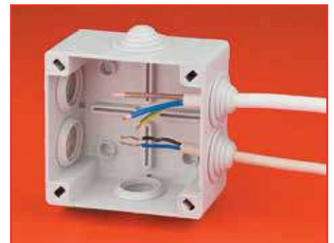
3 этап. Ввод кабеля
