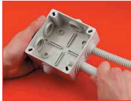
2 этап. Ввод гофрированной и жесткой трубы
