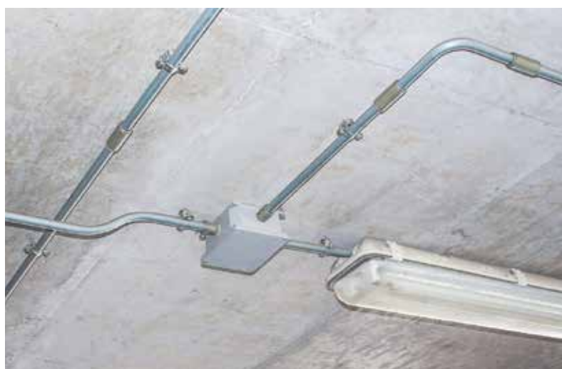
Организация освещения в подвальном помещении. Согласно ПУЭ 6.2.2
