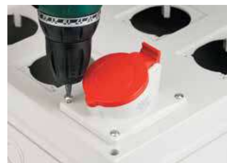
Монтаж розетки на 32 А
