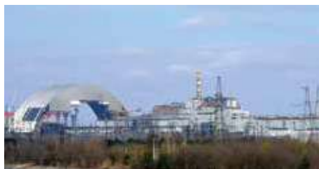
Чернобыльская АЭС, ХОЯТ-2, г. Чернобыль
