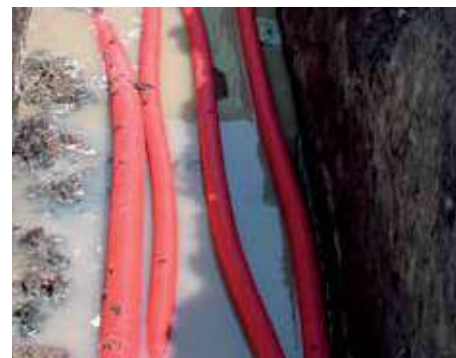
Рис.1 Применение кластеров для многорядной кабельной канализации.
