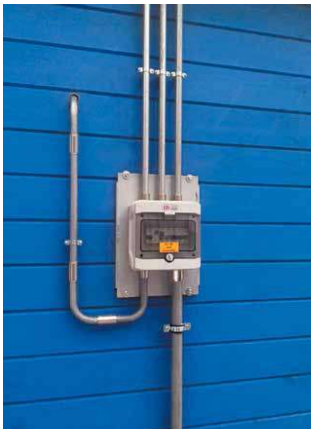
Коттеджный городок в Пуще Водице. Монтаж кабельной системы согласно требований ПУЭ 7.1.22
