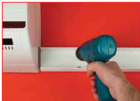
Закрепите основание короба на стене
