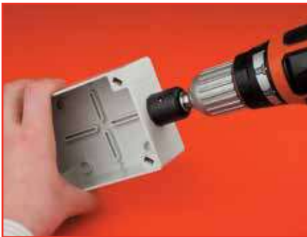
1 этап. Сверлим отверстия необходимого диаметра
