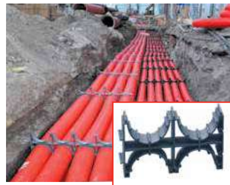
Рис.1 Применение кластеров для многорядной кабельной канализации.
