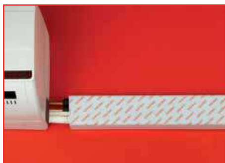
Закройте смонтированную трассу крышкой
