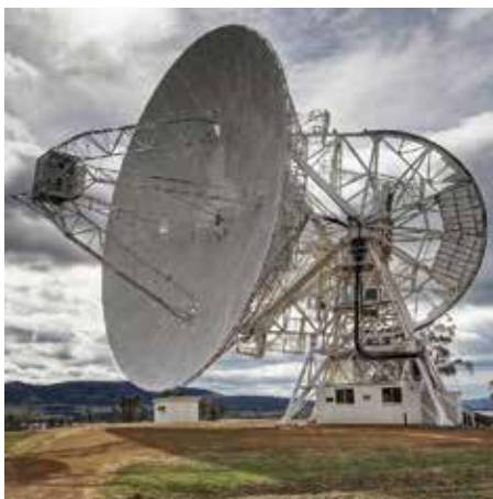
Системы управления и телекоммуникации
