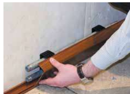
Система закрывается декоративной крышкой
