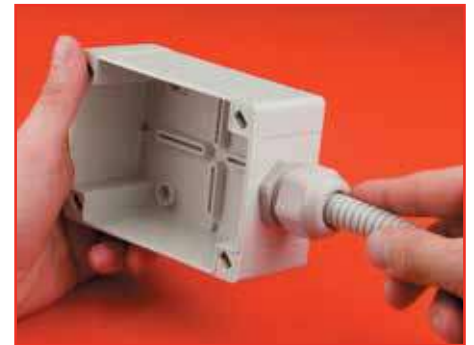
3 этап. Осуществляем ввод трубы и кабель
