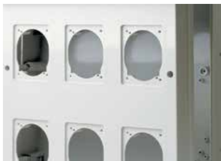
Стандартный фланец для установки розетки на 16 А
