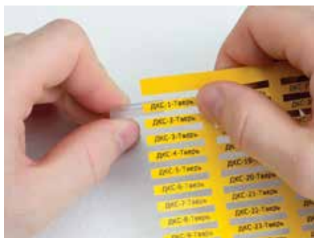
Установить тег в трубчатый держатель
