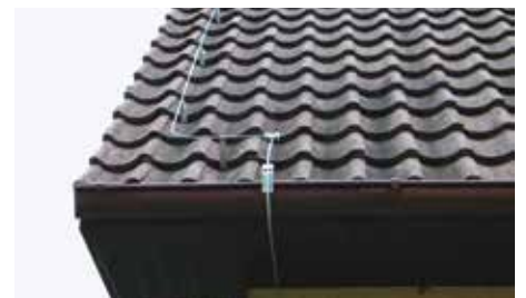
Скатные кровли Создание молниеприемной сетки на скатных кровлях
