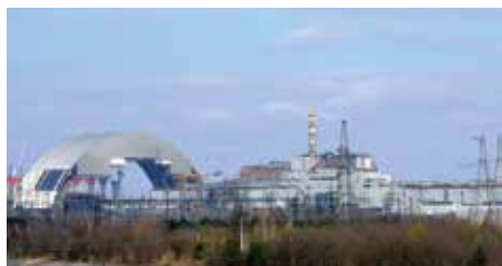
Чернобыльская АЭС, ХОЯТ-2, г. Чернобыль
