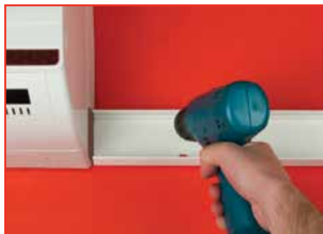
Закрепите основание короба на стене
