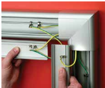
Количество монтируемых проводов заземления в плоском угле
