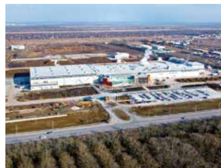
Административные помещения Здания аэропортов, морских и речных портов, вокзалов, промышленные предприятия, заводы и фабрики
