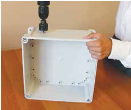
1. Просверлите отверстия
