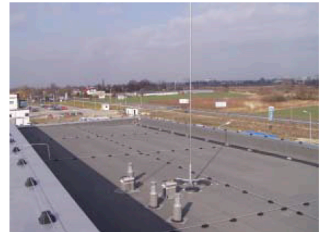
Совместное использование молниеприемной мачты и сетки.
