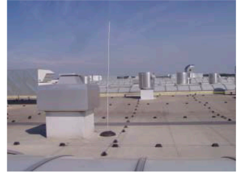
Молниеприемная сетка, смонтированная с помощью пластиковых держателей с бетоном.
