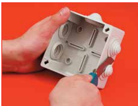
1 этап. Срезаем кабельный ввод
