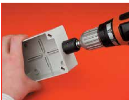
1 этап. Сверлим отверстия необходимого диаметра
