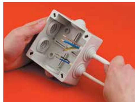
3 этап. Ввод кабеля
