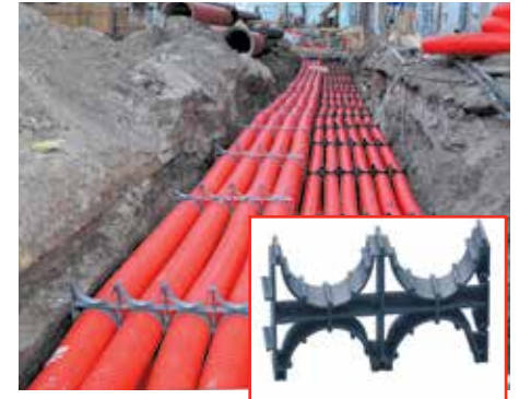
Рис.1 Применение кластеров для многорядной кабельной канализации.
