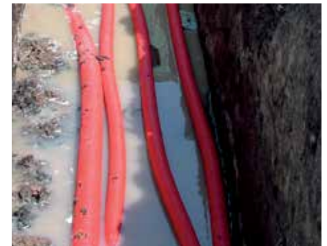
Рис.1 Применение кластеров для многорядной кабельной канализации.
