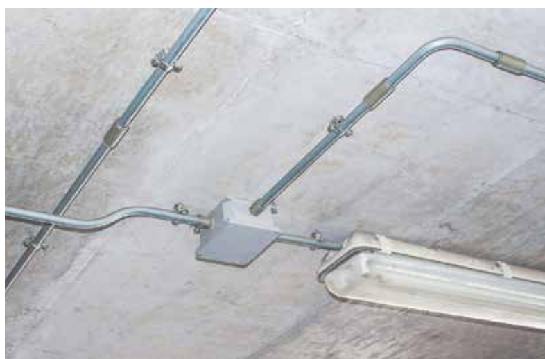
Организация освещения в подвальном помещении. Согласно ПУЭ 6.2.2
