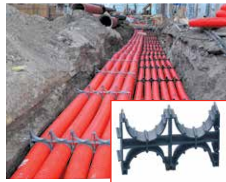
Рис.1 Применение кластеров для многорядной кабельной канализации.
