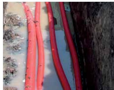
Рис.1 Применение кластеров для многорядной кабельной канализации.
